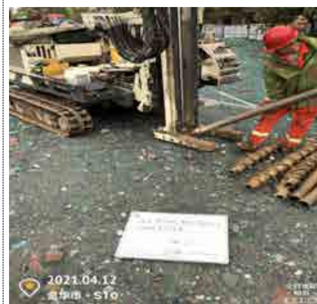
土壤取样钻机架设
