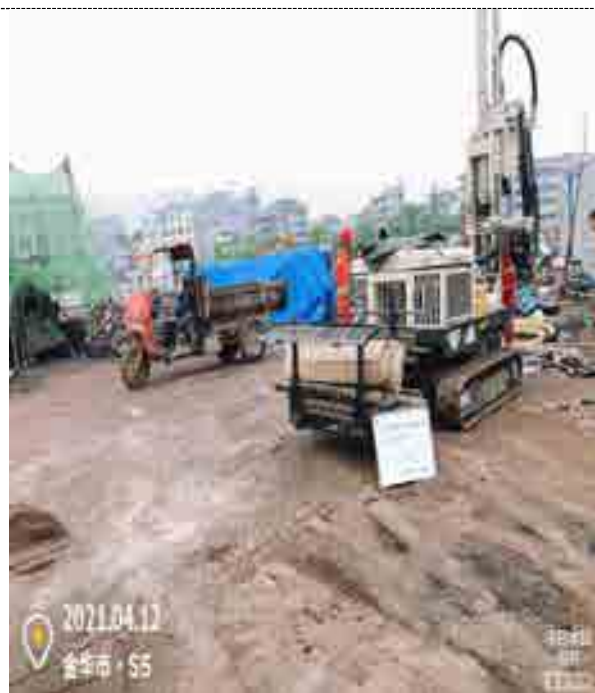
土壤取样钻机架设
