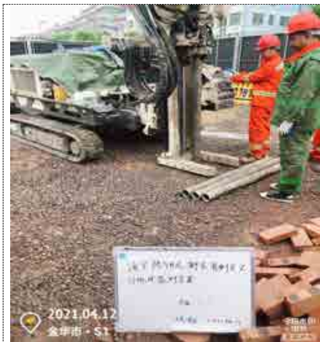
土壤取样钻机架设
