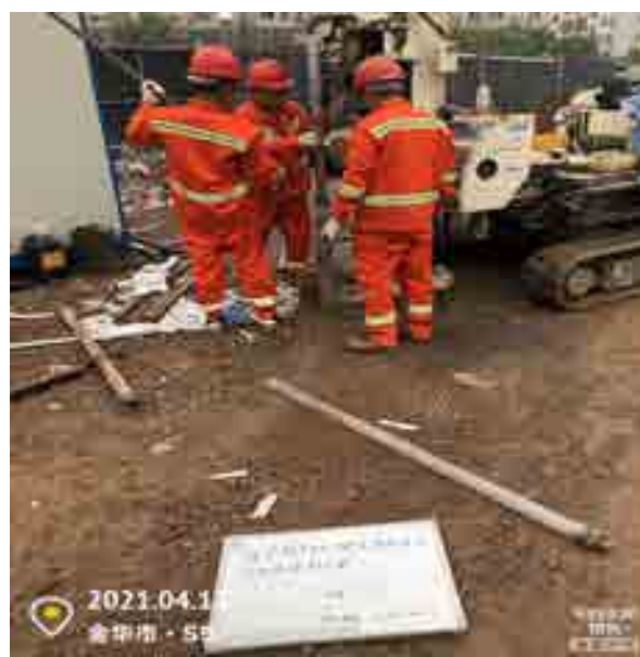
土壤取样钻机架设
